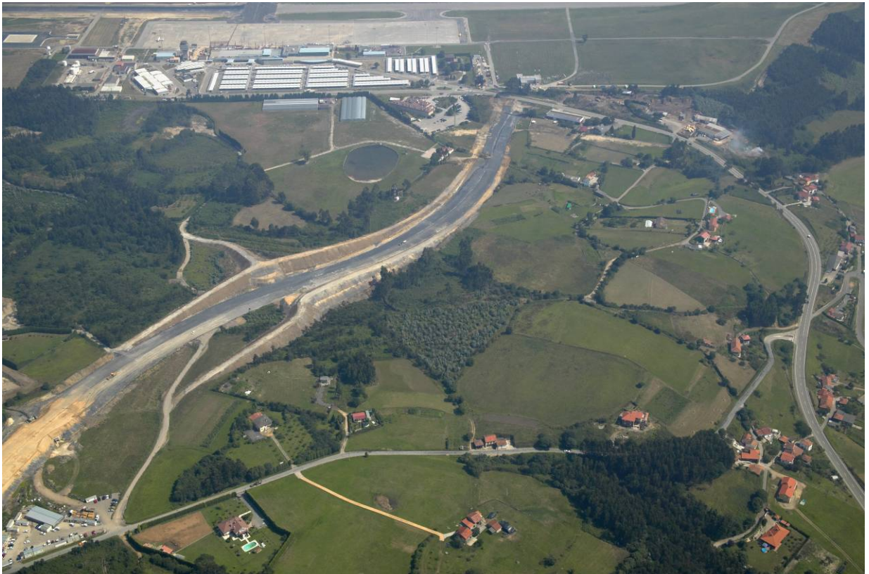
G-07 "AEROPUERTO" (Vista desde el sur)
